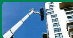
Ny 64 meter lift er gået i luften Side 13
